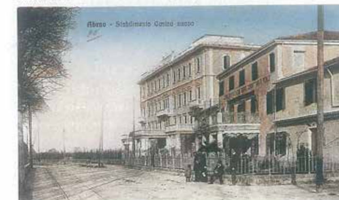
Stabilimento Termale Casino Nuovo (1913)
