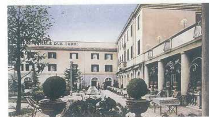
Stabilimento Termale Due Torri (1932)
